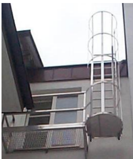
Ausstieg aus dem Fenster mit Aufstieg auf das Dach
